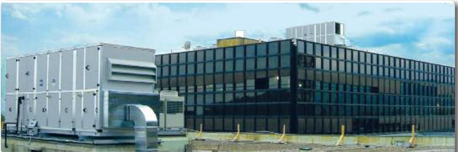
■ **Basamento** perimetrale, esso costituisce un appoggio perimetrale continuo delle unità e permette di scaricare il peso su una superficie maggiore sollecitando al
