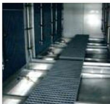
Speciali grigliati pedonabili possono essere realizzati per quelle sezioni ove si preveda un frequente accesso di personale autorizzato, quali vani tecnici che alloggiino quadri elettrici di controllo e potenza o sezioni idrauliche.
