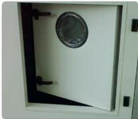
volantini di chiusura, a seconda delle esigenze e delle possibilità specifiche dell'applicazione. Le zone ispezionabili in depressione avranno aperture con rotazione verso l'esterno - le zone ispezionabili funzionanti con valori di pressione positive avranno aperture con rotazione verso l'interno. In ottemperanza alla Direttiva Macchine CE conformità 89/392, relativa alla sicurezza sulle sezioni moto ventilanti, viene installata, posteriormente alla portina di ispezione, una controportina
