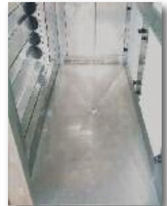
■ **Portine di ispezione** realizzate con lo stesso processo di formazione delle altre pannellature e negli spessori 50mm e 100mm a seconda del tipo di profilato impiegato,
